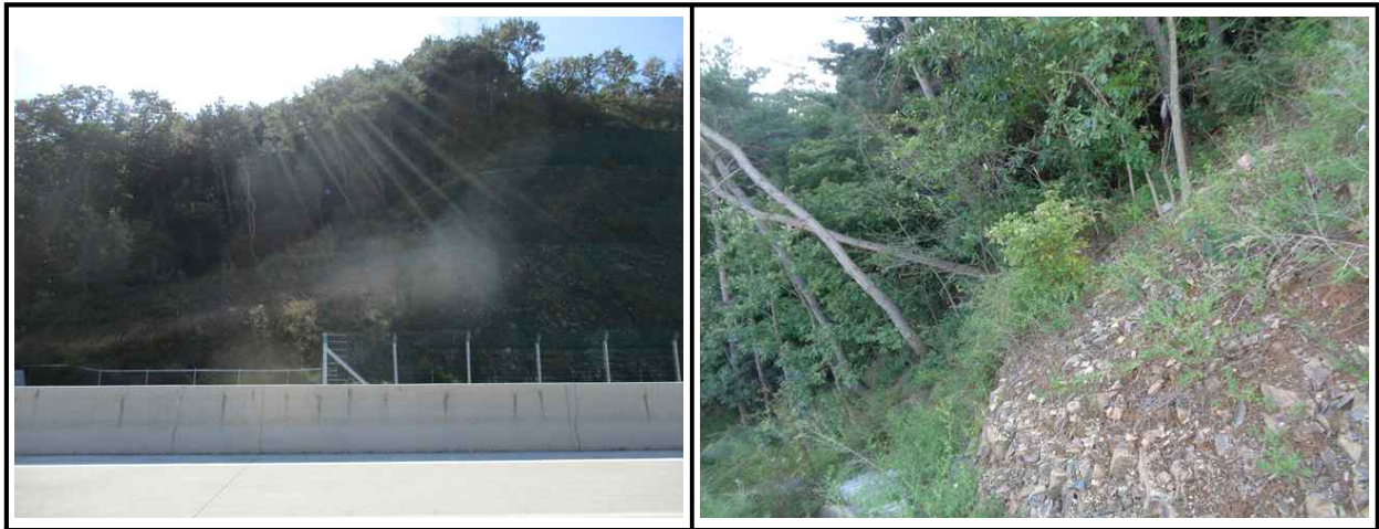
【그림 57.3.1】 상부자연사면 전경
