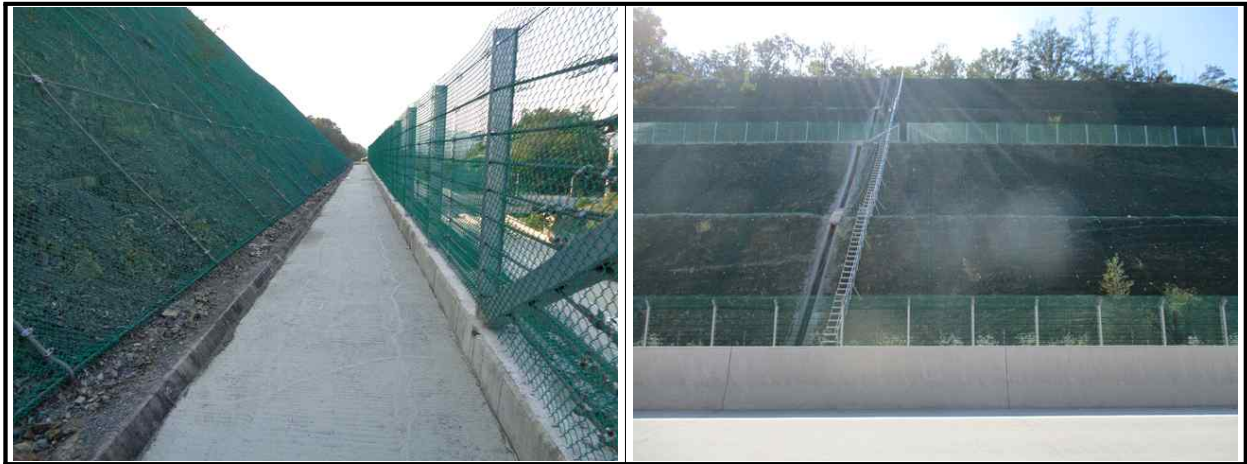
【그림 57.3.3】 배수시설 전경
